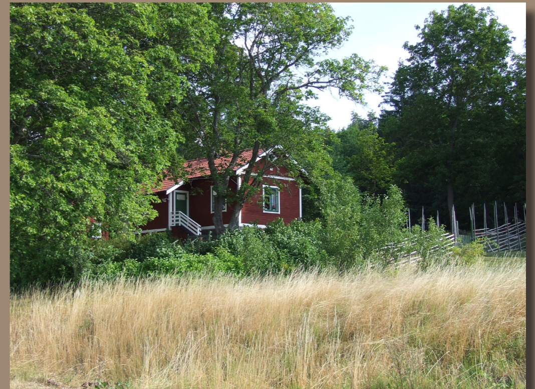
Funbo banvaktstuga norr om korsningen mellan Marielundsvägen och Lennabanan. Stugan där takfallet förlängs över farstun är av en typ som förekommer på fler ställen på sträckan Länna- Norrtälje.
