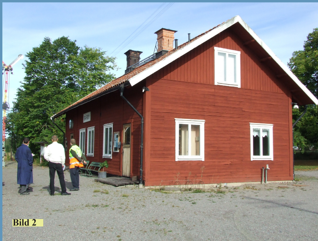
Bärby stationshus från öster. Huset är av standardmodell för Lennabanan som fanns både i Almunge, Faringe och Knutby. I mitten av 50-talet förlängdes byggnaden åt öster och den utstickande vindstrappan som är utmärkande för hustypen byggdes in.
