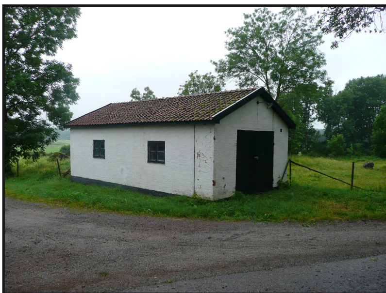
Byggnaden där brandstationen var inrymd. Huset ligger på höger sida, före Marielunds gård, om man kommer från Uppsala
