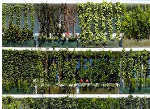
Gröna väggar och växtlådor på loftgångar in mot gårdsmark
