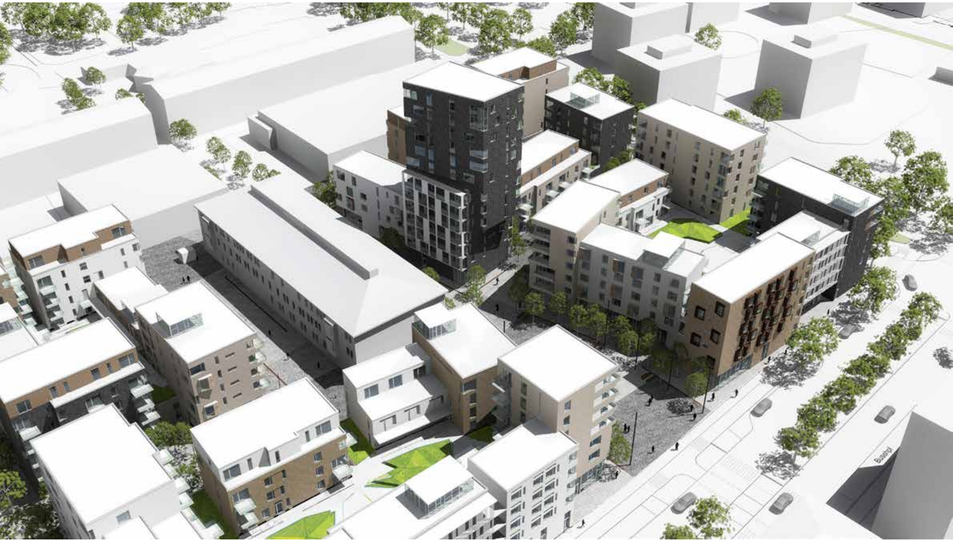
Varierande byggnadsskalor och rumsliga förlopp skapar upplevelsesrikedom i området.
