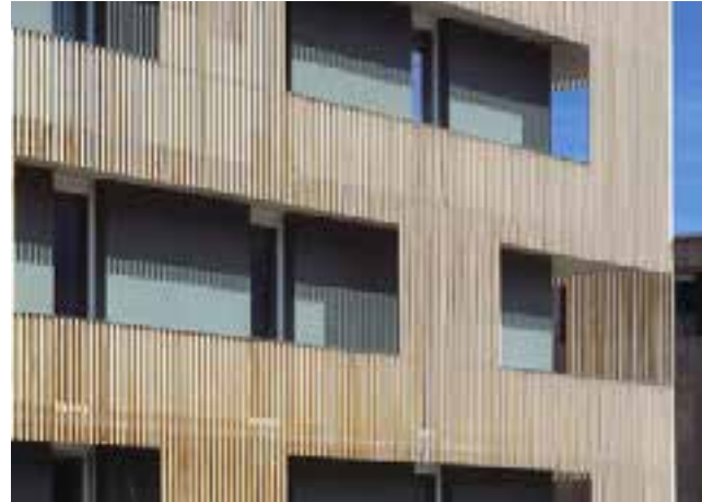
Loftgången syns inte men framstår som fasad i trälameller med fönsteröppningar
