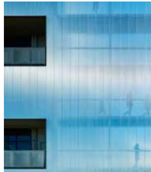
Heltäckande translucent skärmfasad i polycarbonat med ett par få öppningar
