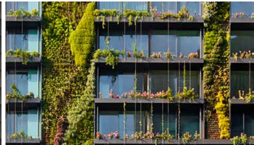
Grön fasad mot gårdsmark och mellan gård och gata
