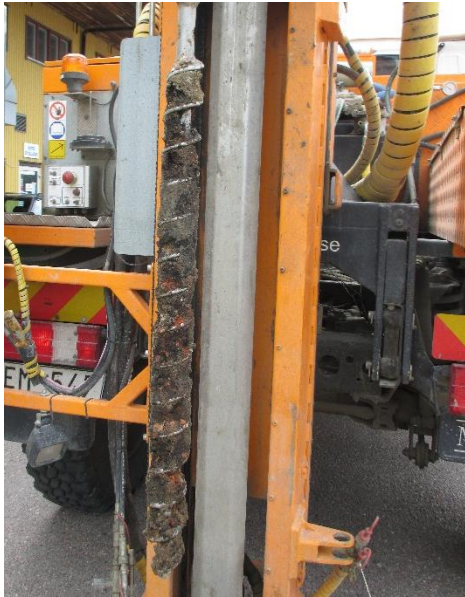
Bild 3A: 14BM04, 1-2 m Provtagning av sandig, lerig fyllning med inslag av tegel och svarta partier.
