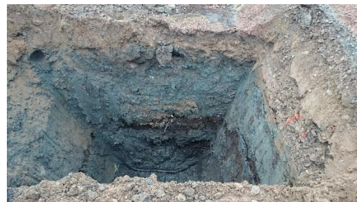
Bild 4B: 14PG1 Överst 0,8 m med sandig, grusig fyllning, därunder lera och soplager. Provgropens djup 3,1 m.
