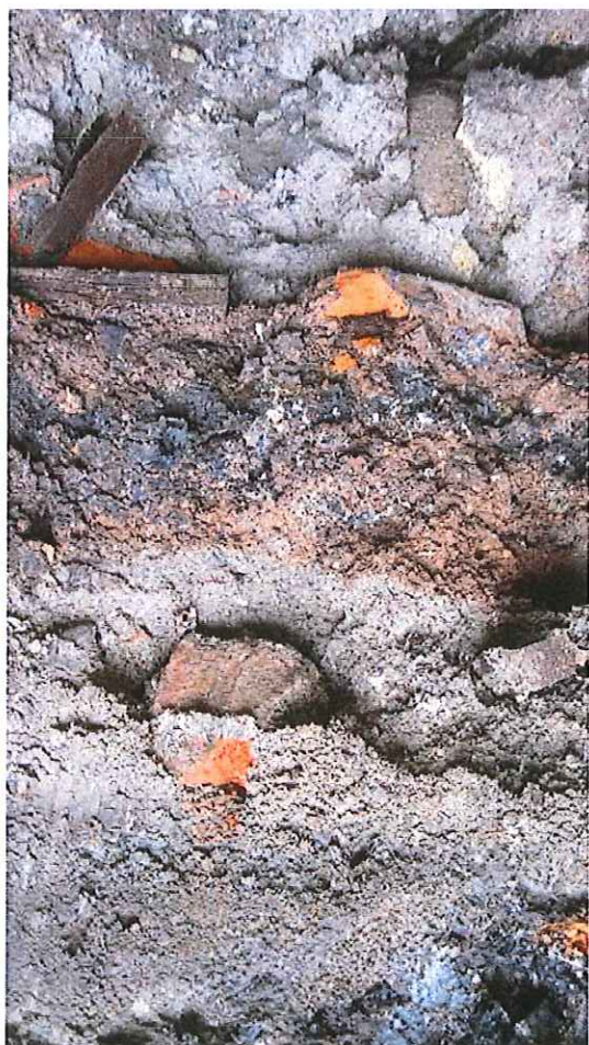
Bild 1. Skiktning i provgrop C
