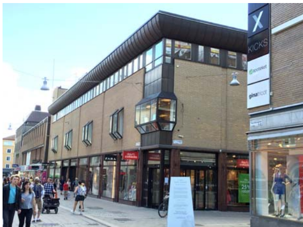
Byggnaden sedd från Svartbäcksgatan
