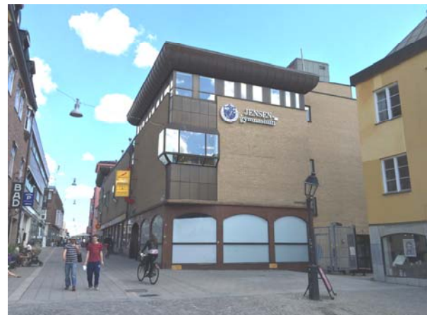
Byggnaden sedd från Gamla torget
