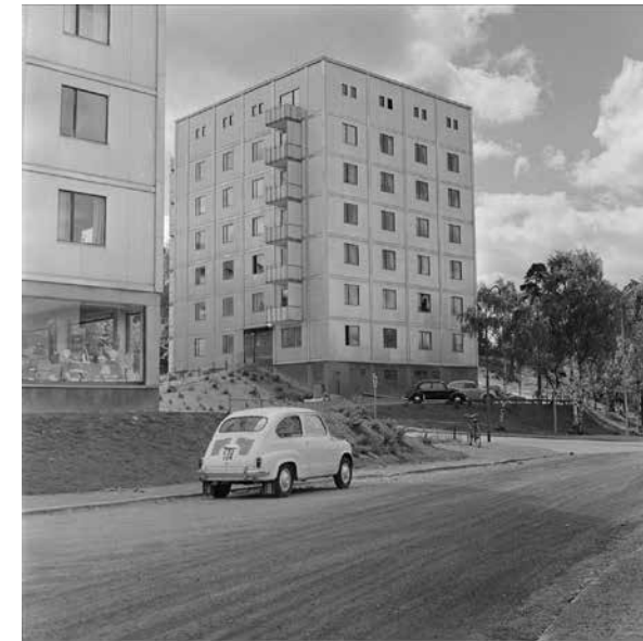
De båda punkthusen flankerar Karlsrogatan och bildar entré till bostadsområdet Eriksberg.
