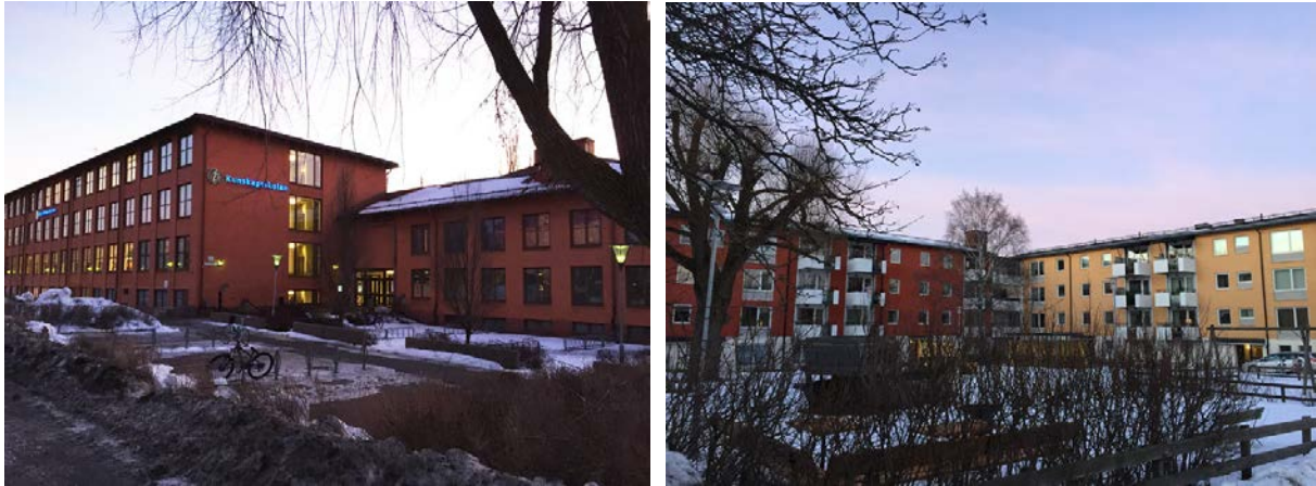
Byggnaden "Magistern", fasad mot Dag Hammarskjölds väg till vänster respektive flerbostadshus i norr till höger
