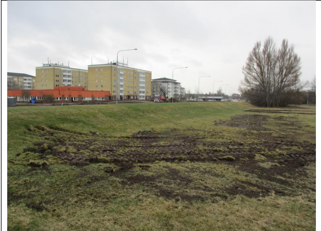
Bild 1. Vy mot vall och Gamla Uppsalagatan
