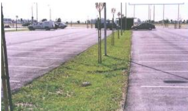
Figur 3 Ytterligare exempel på öppen avledning på tomtmark. Parkeringsytorna leds direkt till ett öppet dikesstråk där fördröjning och viss fastläggning av
