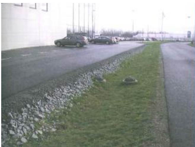
Figur 2 Exempel på hantering på tomtmark. Hårdgjorda ytor leds direkt till gröna dikesstråk där dagvattnet kan fördröjas. Vid höga flöden låts dagvattnet brädda till dagvattenledningarna som ansluts till kommunal dagvattenledning i gatan.
