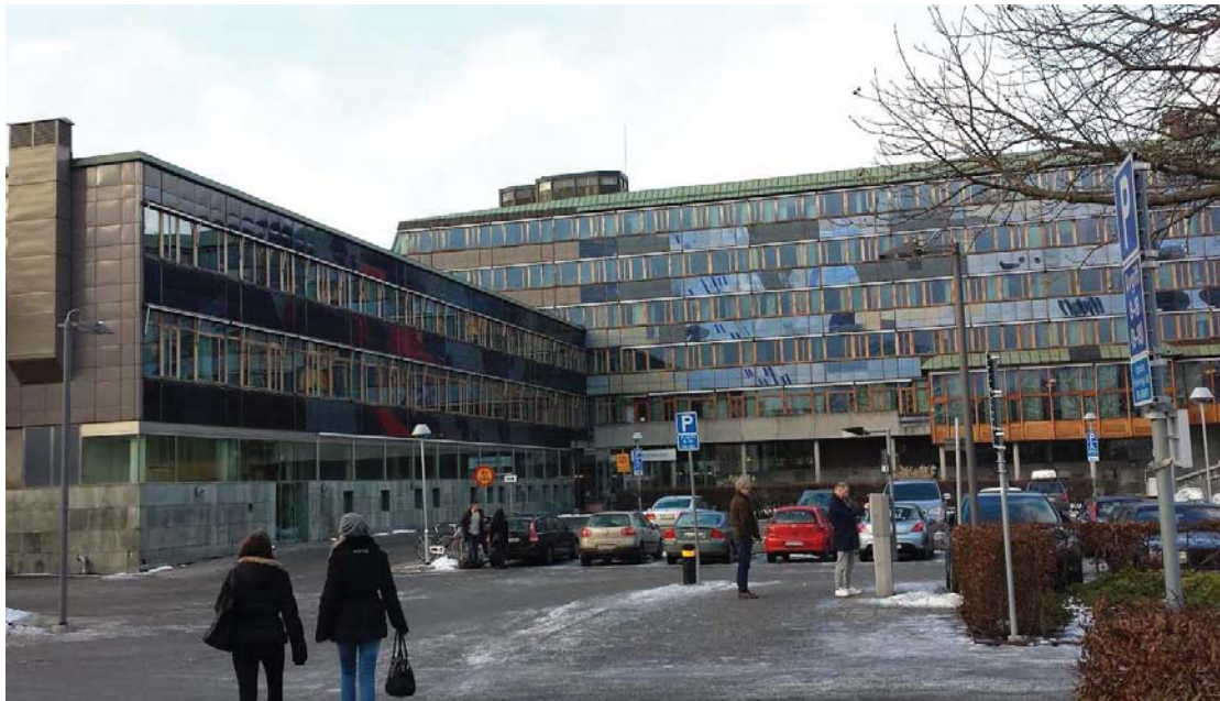
Figur 4. Stadshuset sett från innergården/parkeringsytan.
