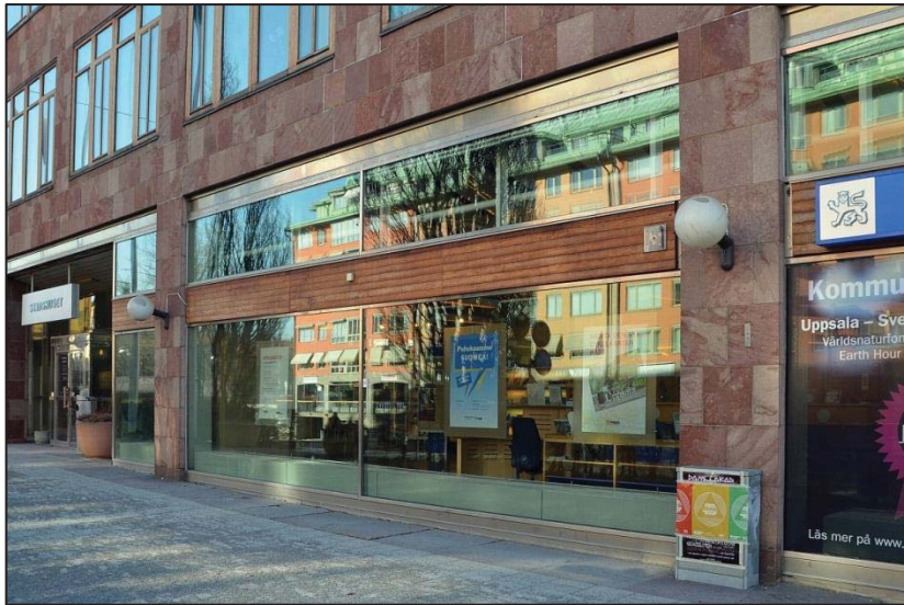
Fasad mot nordväst med stora skyltfönster horisontellt avdelade med teakpanel. Fasad mot Vaksalagatan.
