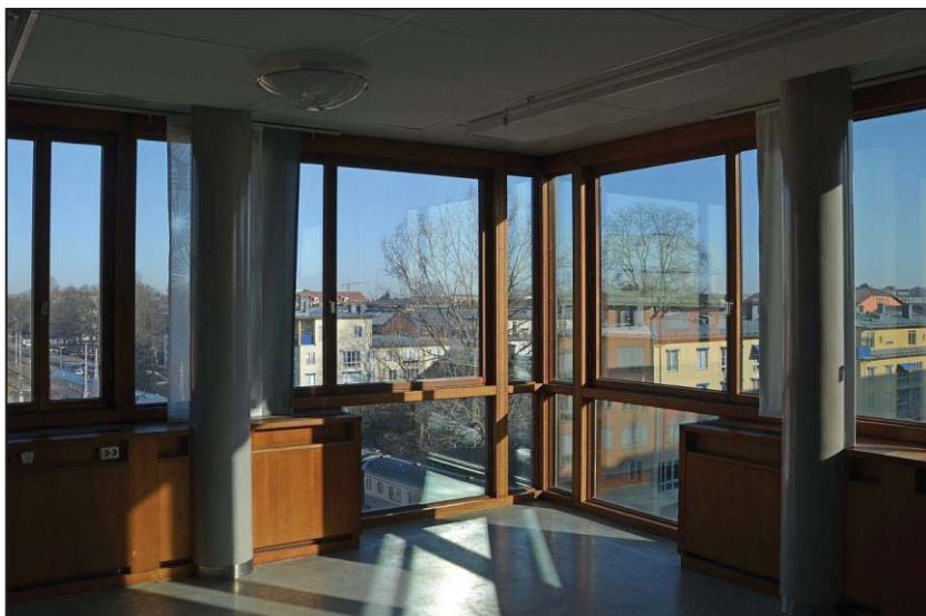
Hörnen i de fjärde och femte våningarna har glasade bröstningar.
