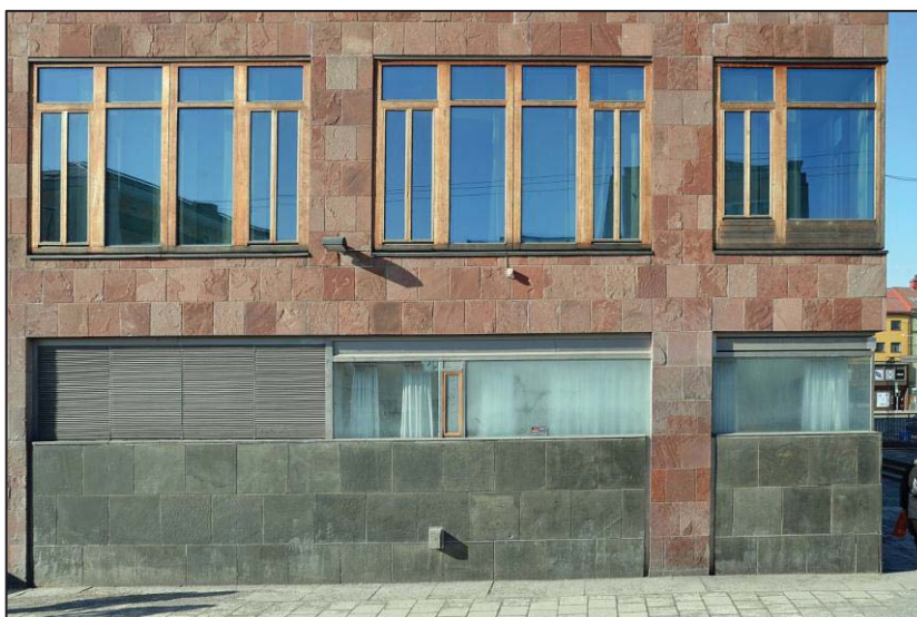
Byggnadens nordöstra hörn visar fasadmaterialens behandling, med fönsterpartier i teak omgivna av plattor av äldalsandsten och med en sockel av grå skiffer. På ett för tiden typiskt sätt är fönstret hörnomslutet, och därmed visar man att fasadskivorna är just fasadskivor och inte utgör en del av byggnadens bärande funktion.
