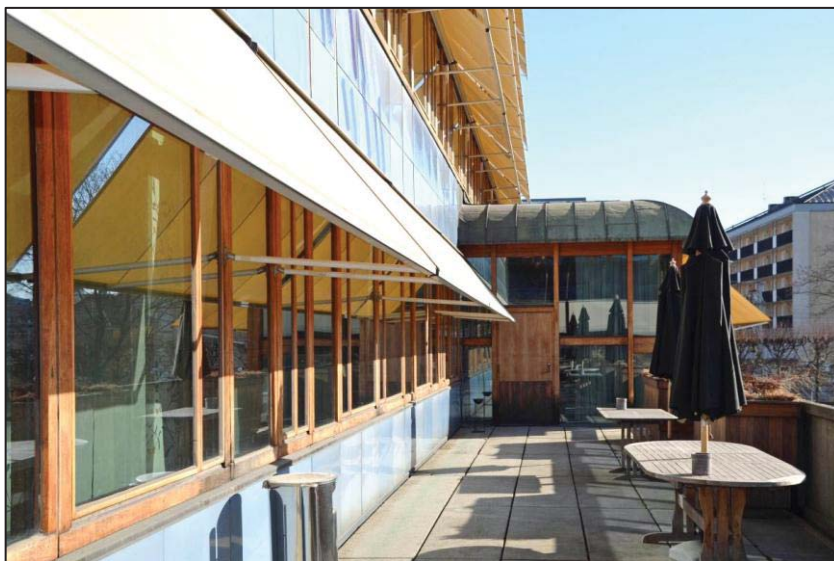
Balkong till KS-salen. Balkongen var en utökning av tävlingsförslaget.
