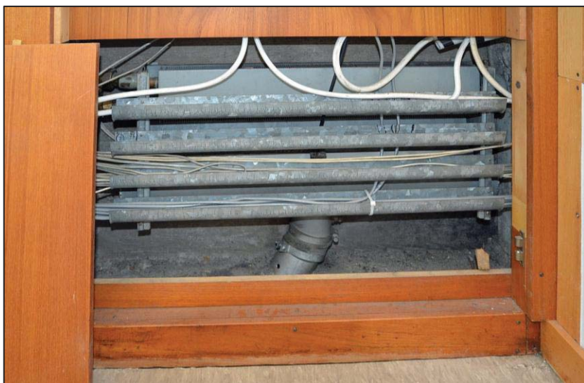
Bröstningskåp med kablage.
