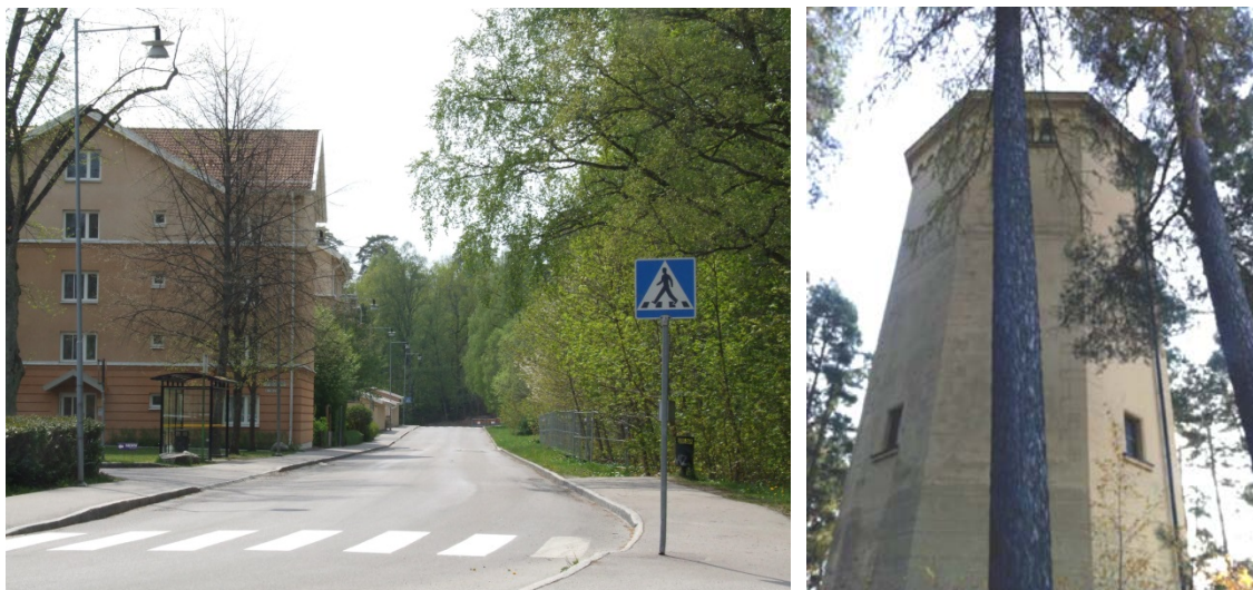
Foto som visar Ulleråkersvägen, sedd från korsningen med Gustaf Kjellbergs väg. Planområdet till höger i bild. Foto till höger visar vattentornet från år 1900 (hus 22).
