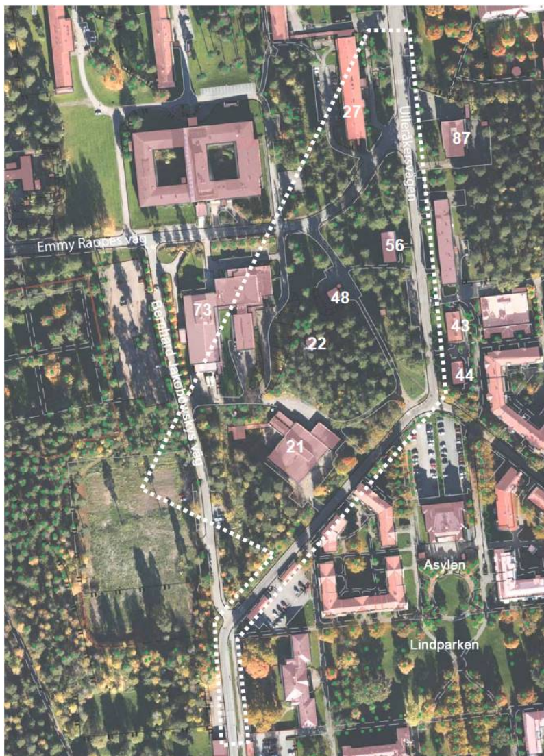
Figur 2.4.5. Flygfoto med planområdet markerat med vit streckad linje. Bebyggelsen inom området är i tur och ordning matsal (73), sjukhusbyggnad (27), vattentorn (22), portvaktstuga (48), Bostadshus sköterskor (56), verkstad (21) (Uppsala kommun 2016).
