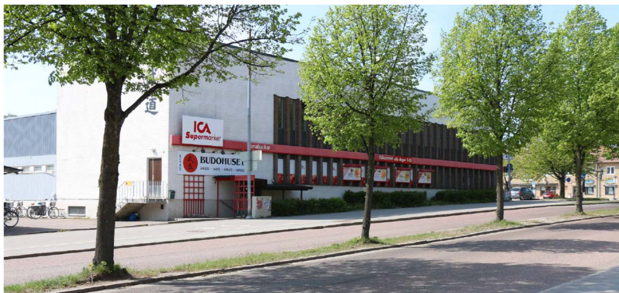
Befintlig byggnad med vissa kulturhistoriska värden.
