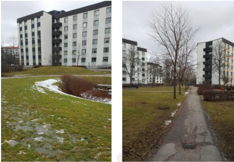
Figur 4: Bilder från platsbesök 2016-03-10. TH: Marken visade tecken på att vara vattenmättad på många ställen. TV: Dålig infiltrationskapacitet vägdes upp av flera dagvattenbrunnar inom planområdet.
