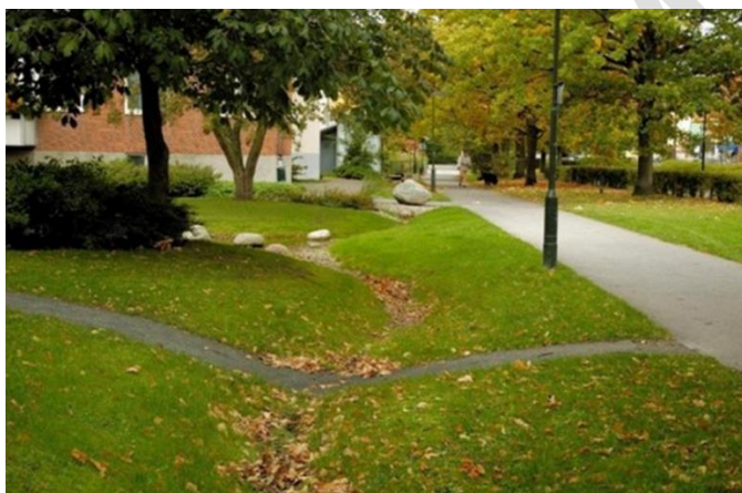
Figur 12: TV: Svackdike bredvid gång- och cykelväg. TH: Principutformning svackdike.
