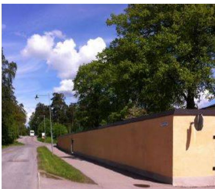
Figur 4.5.8. Ulleråkersvägen vy mot norr
