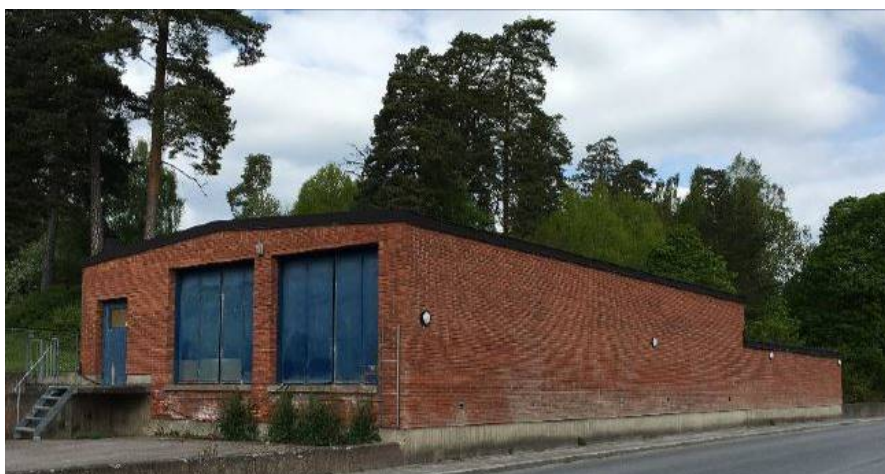
Figur 4.5.6 Byggnad för tvätthantering invid Ulleråkersvägen (hus nr 76) innan rivning
