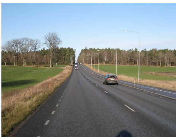
Figur 2.4.11. Vy mot Ulleråker från söder
