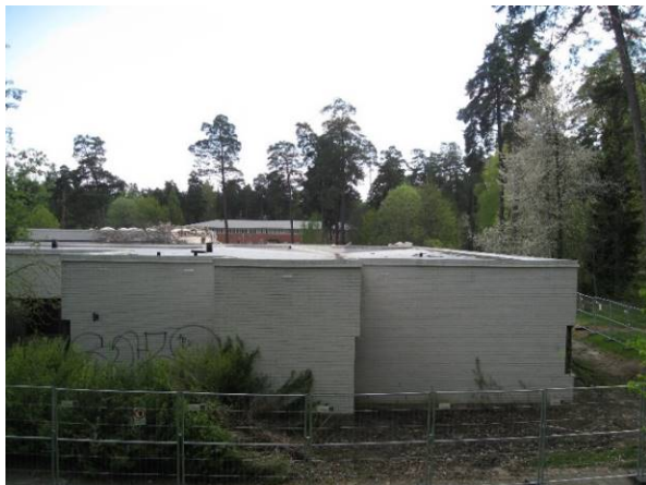
Figur 2.4.2. Byggnad 78 Neurologiskt centrum innan rivning
