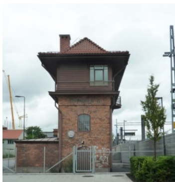
Sidovy ställverk (från söder).
