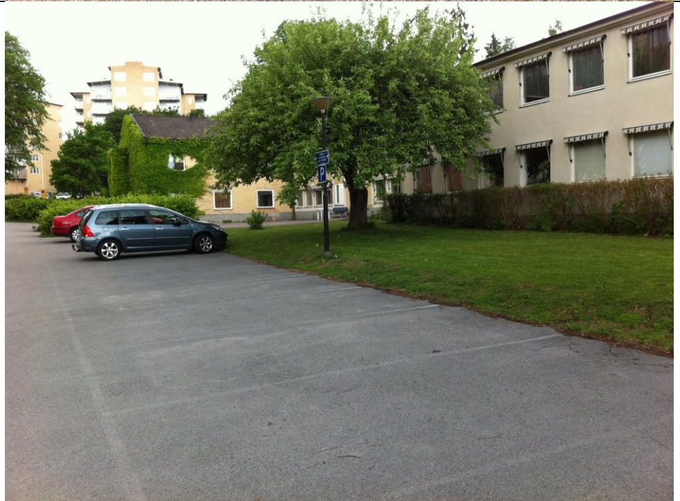
Foto 4. 2013-06-14 Asfalterad parkeringsyta längs byggnadens södra långsida.
