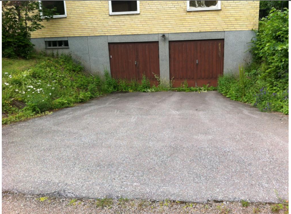
Foto 3. 2013-06-14 Asfalterad nedfart till garage i källarplan från byggnadens norra sida.
