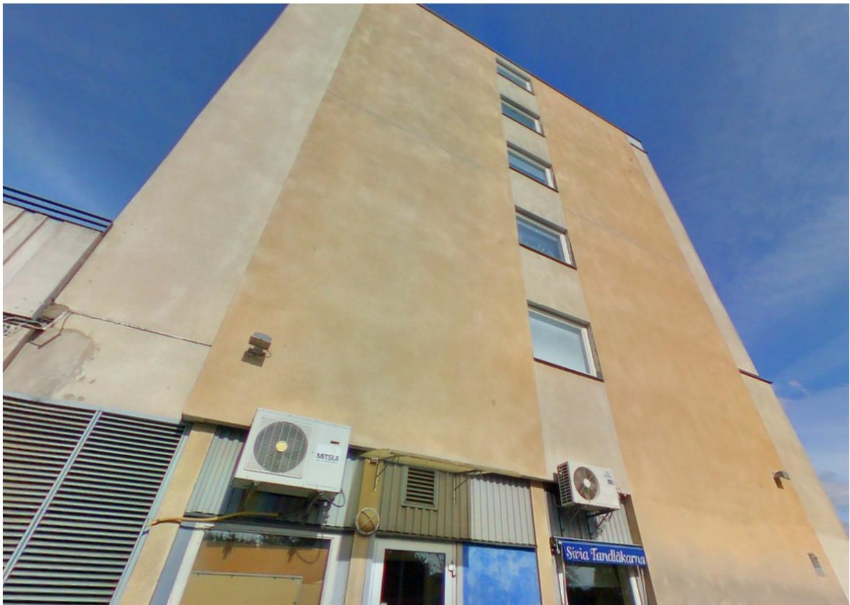
Figur 16. Fasad i befintlig byggnad som vetter mot järnvägen.
