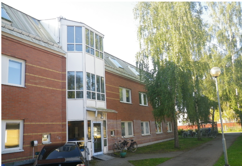
Figur 5. Huvudentré för byggnaden på fastigheten Kvarngärdet 62:2. I bakgrunden kan järnvägens nuvarande plank skönjas. Planket ligger väster om spårområdet. Källa: Briab
