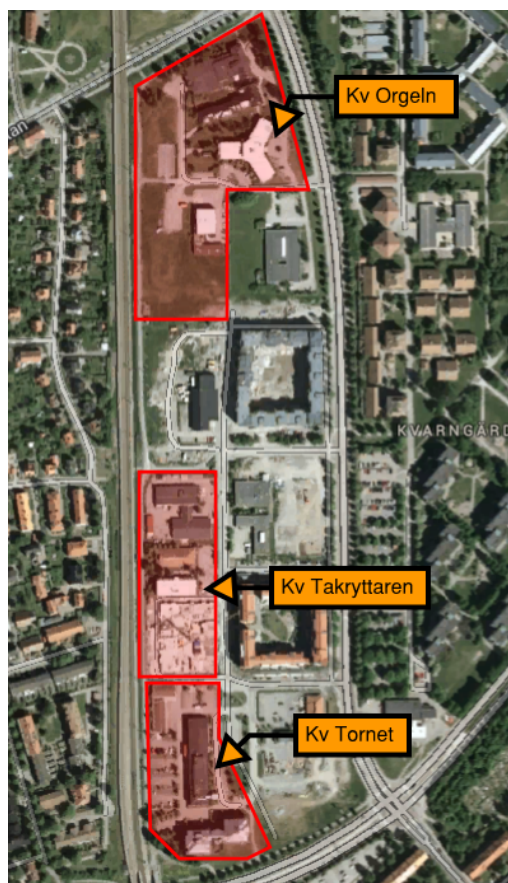
Figur 1. Intill Ostkustbanan ligger bland annat kv Tornet och kv Orgeln, för vilka tidigare upprättats riskbedömningar. Aktuellt kvarter, Takryttaren, ligger mellan dessa. Bildkälla: (Google, 2014)
