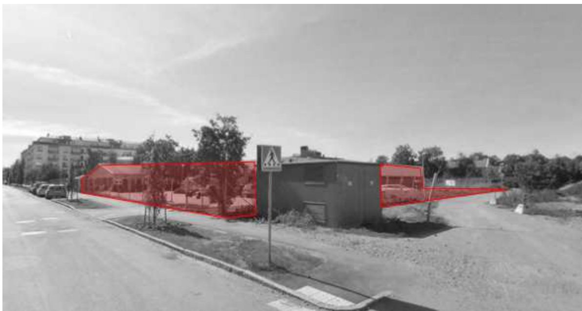
Figur 5. Kvarngärdet 1:8 och 62:1 sett från korsningen Portalgatan-Kapellgatan. Fastigheterna ligger inom det rödmarkerade området. Bildkälla: (Eniro, 2014). Redigerad av Briab.
