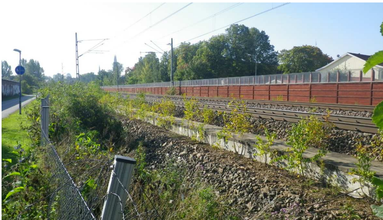
Figur 8. Järnvägen ligger ungefär 15 meter från fastighetsgränserna. Foto taget mellan järnvägen och fastigheterna i riktning mot järnvägen. Källa: Briab
