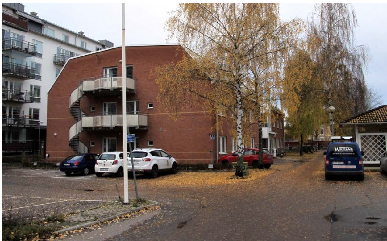
Fastigheten Kvarngärdet 62:2 i den södra delen av planområdet med den befintliga kontorsbyggnaden i november 2013.
