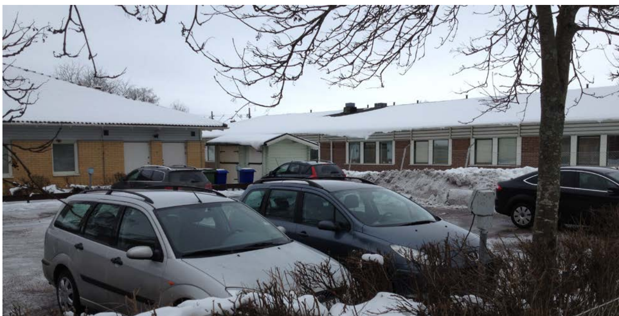
Fastigheterna Kvarngärdet 1:8 och 62:1 i den norra delen av planområdet i februari 2013.
