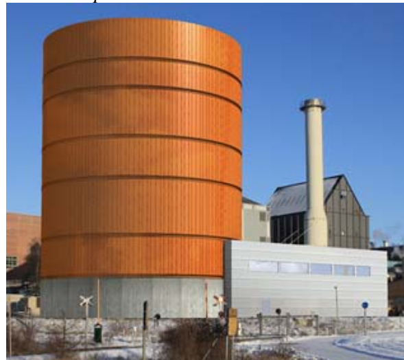
Teknikbyggnaden till höger
