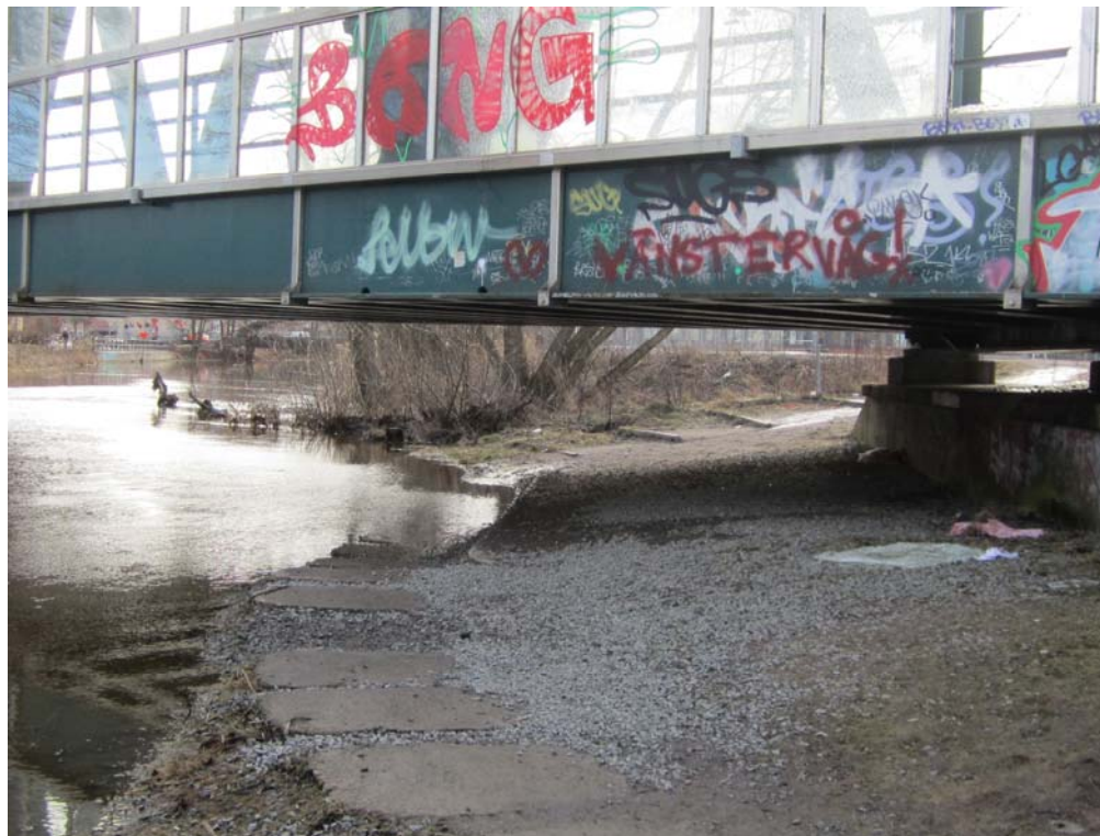
Idag finns en provisorisk passage under järnvägsbron i anslutning till planområdet.
