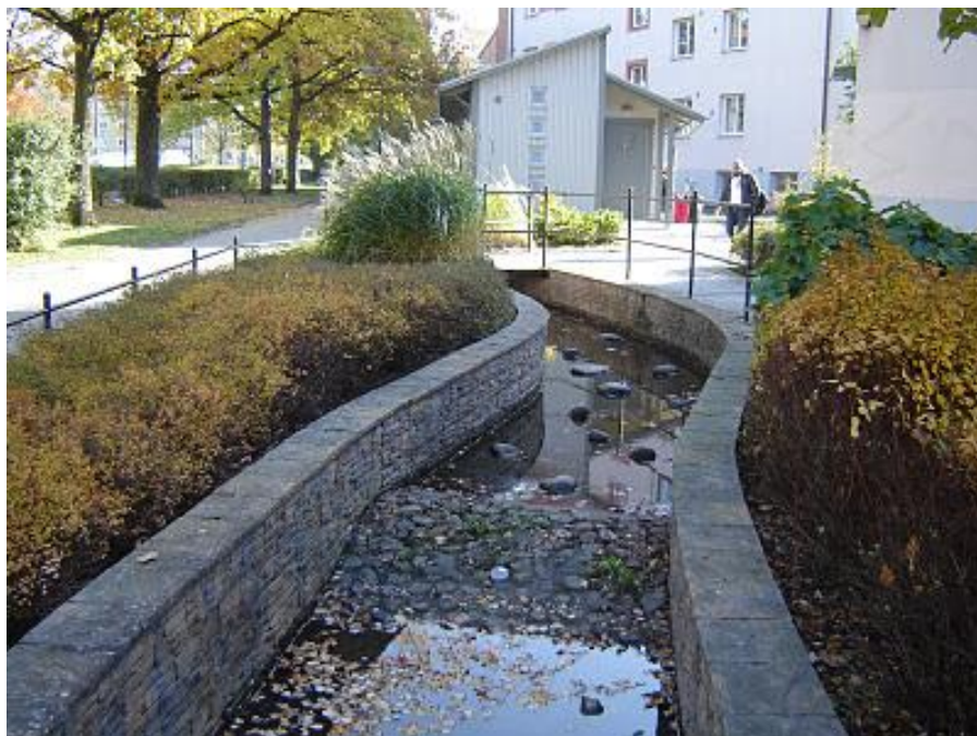
Inspirationbild 9 Öppen kanal för dagvatten.
