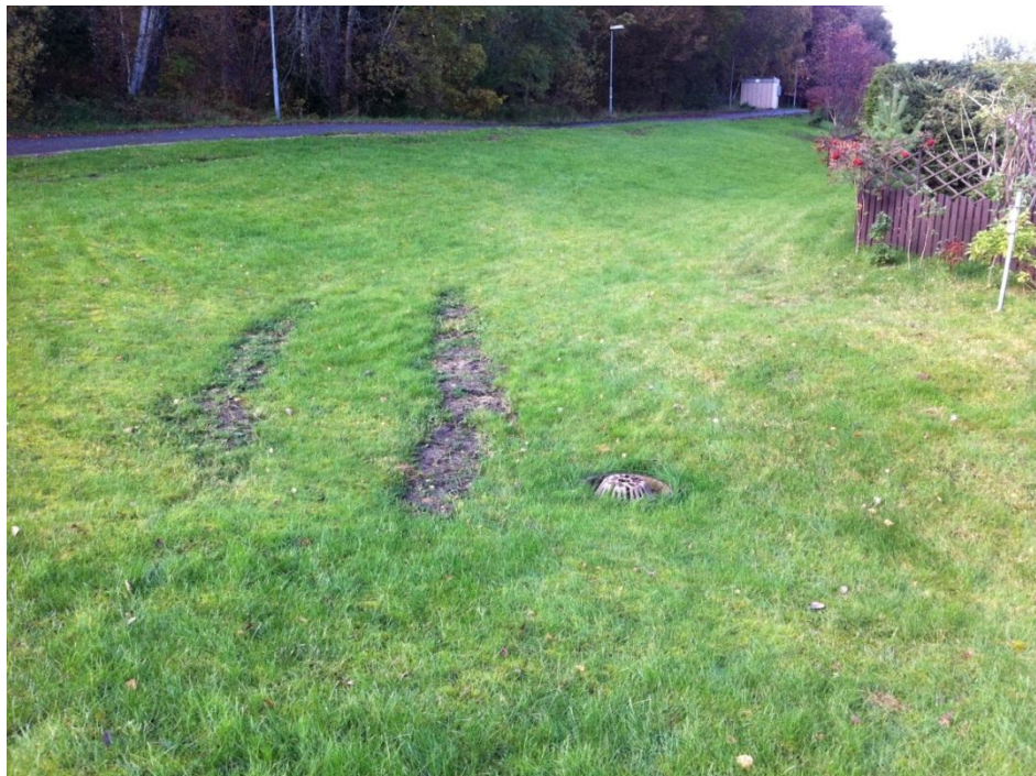
Inspirationsbild 6 Gräsbeklädd översvämningssyta som avvattnas till kupalbrunn
