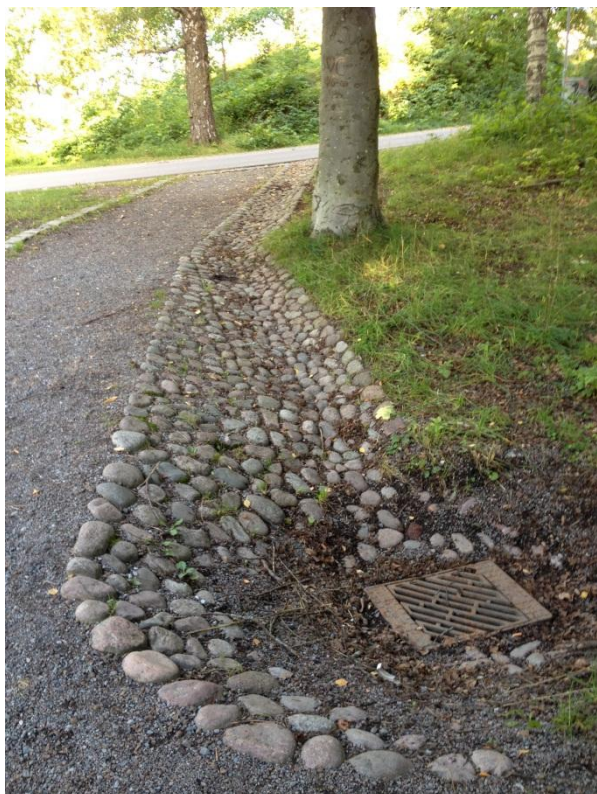
Inspirationsbild 3 Stenbeklätt dike med avvattning till dagvattenbrunn
