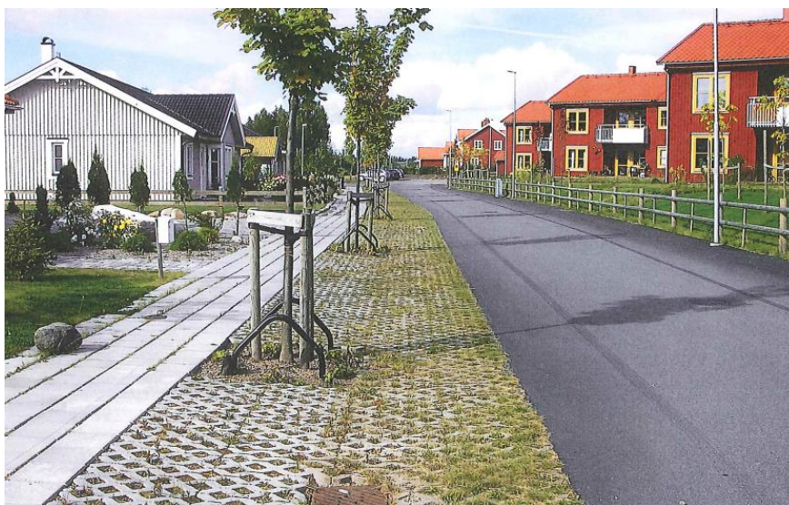
Inspirationsbild 2 Infiltrationsstråk av armeringssten och träd mellan körbana och GC-väg
