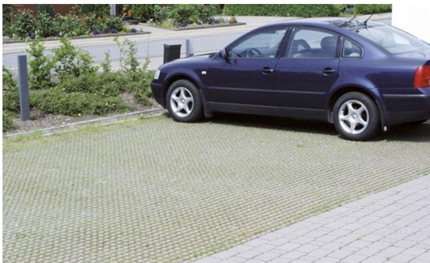
Inspirationsbild 1 Parkering belagd med armeringssten för infiltration av dagatten.
