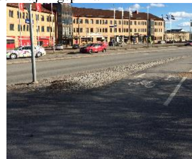
Gång- och cykelbanan längs Stålgatan strax söder om övergångsstället med cykelpassage.
