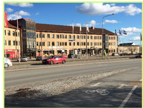
Kontorshus på östra sidan av Stålgatan
