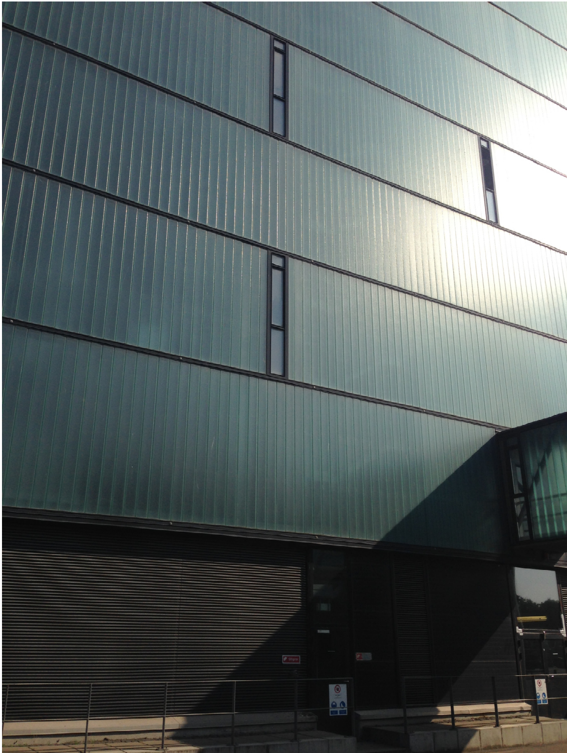
Bild 2. Sommartid när solen står högt på himlen kan fasaden upplevas bländande på nära håll, då man vänder sig mot fasaden i den vinkel som solen skiner från.
