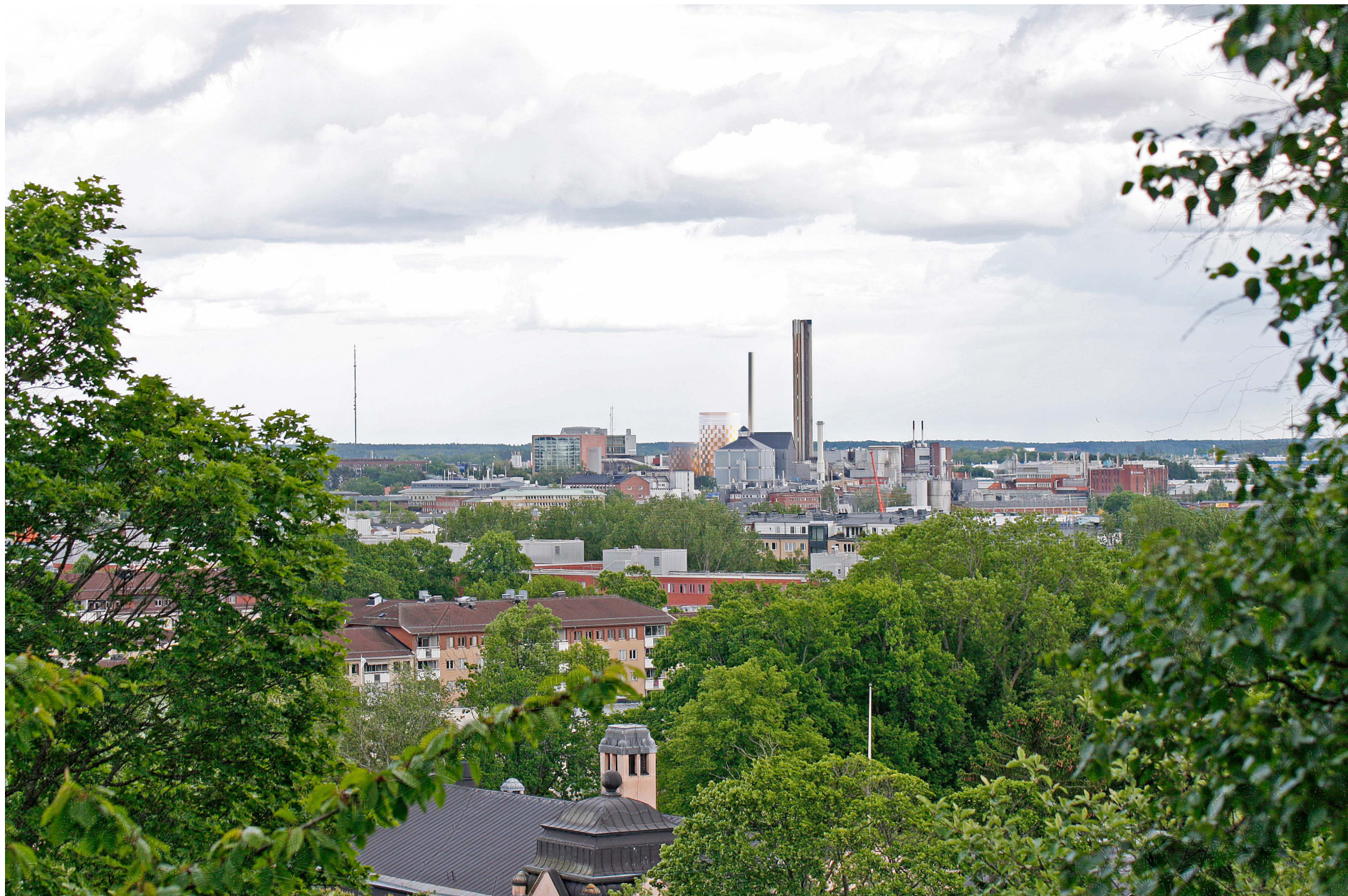
Vy från Uppsala slotts östra sida. Här syns den nya pannbyggnaden bakomrökgasreningssystemet från 1992. Pannbyggnadens fasader är av profilglas i rött och vitt som bildar ett raster som löses upp ju närmare krönet man kommer. Övre delen av fasaden har på håll en ljus färg som får en delvis diffus karaktär som kan tyckas smälta in i den ljusa bakgrundshimlen. Fotomontage Liljewall arkitekter.
