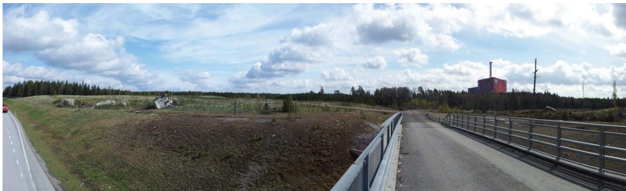
Figur 12. Kraftvärmeverket sett från den befintliga bron (enskild ägoväg) över E4 i riktning österut. Till vänster i bild skymtar det norrgående körfältet på motorvägen och början av avfartsrampen in till Storvreta.
