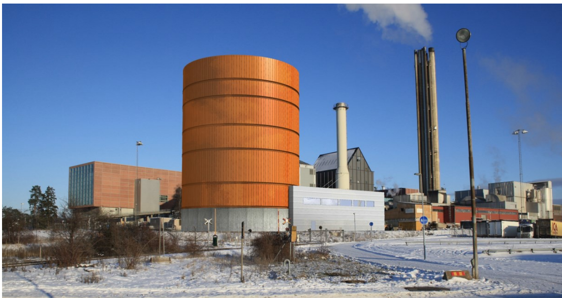
Illustrationen ovan visar kyllagertornet täckt med slät cortenplåt och ett tungt betongfundament. Komplementbyggnaden till höger är nedtonad och täckt med grå metallplåtar. Illustration: Liljewall Arkitekter.
