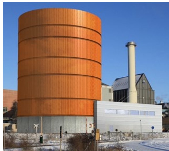
Slät cortenplåt på kyllagret och grå slät plåt på teknikbyggnaden till höger
