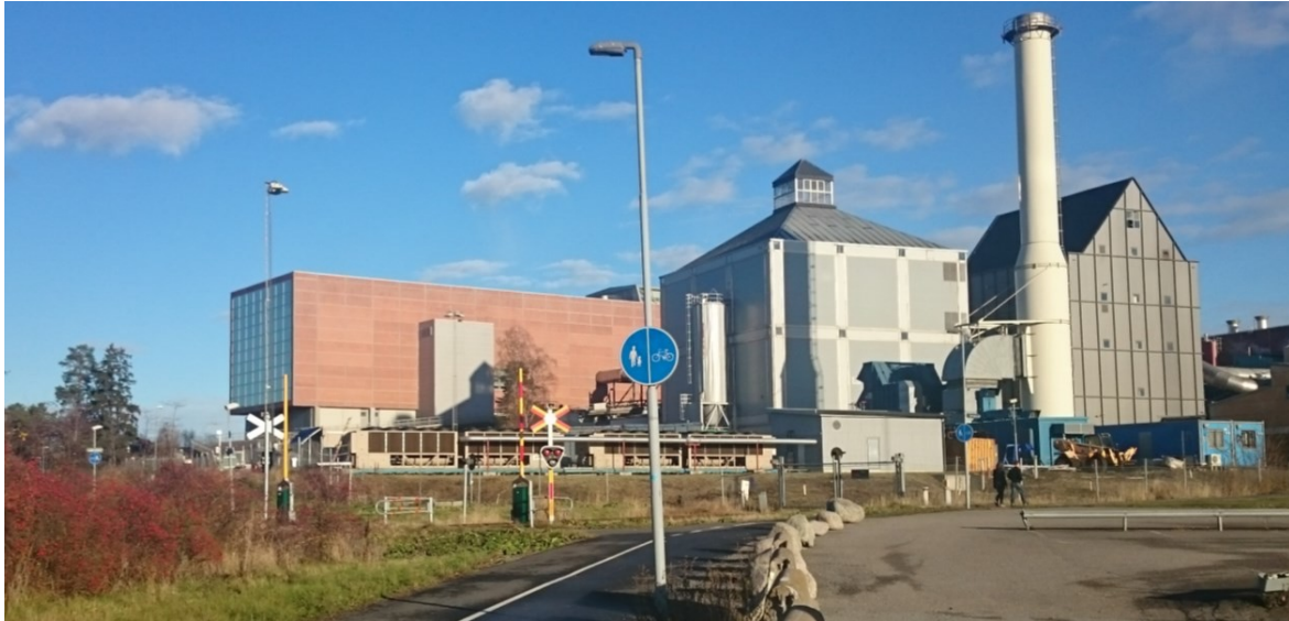
Planområdet sett från Danmarksgatan. Från vänster till höger i bilden ovan: Avfallsförbränningsanläggning ("Block 5") 2002 (Arkitekt Magasinet AB) Rökgasreningsanläggning 1992 (Uppfeldt och Wallerstedt arkitektkontor) Byggnad för absorptionsvärmepumpar 1998 (Uppfeldt och Wallerstedt arkitektkontor)
