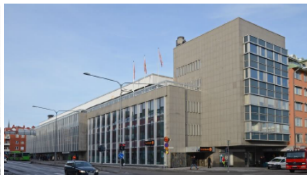
Sparbankshuset som det såg ut 2015. Med bostadsbyggnaderna som uppfördes intill sparbankshuset under 1990 förändrades upplevelsen av sparbankshuset som en solitär byggnad.
