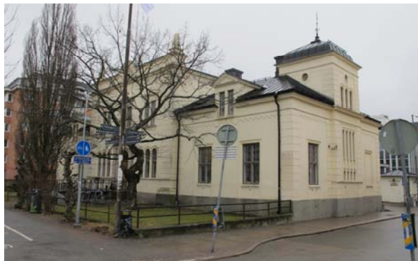
Tingshuset så som det ser ut 2016.
