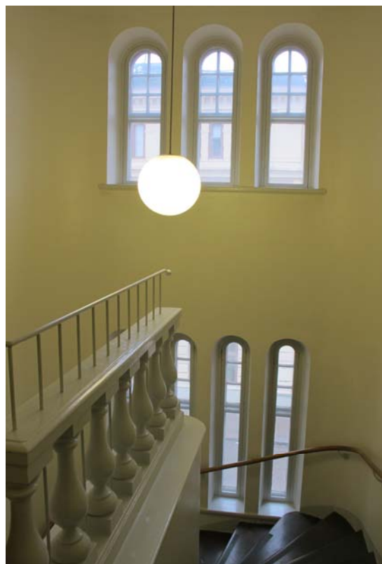
Trapphus med balustrad.
