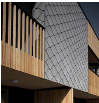
Ivaskiffer- fibercement med portlandcement som bindemedel
