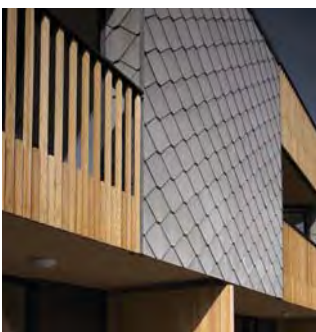
Ivarskiffer- fibercement med portlandcement som bindemedel.
