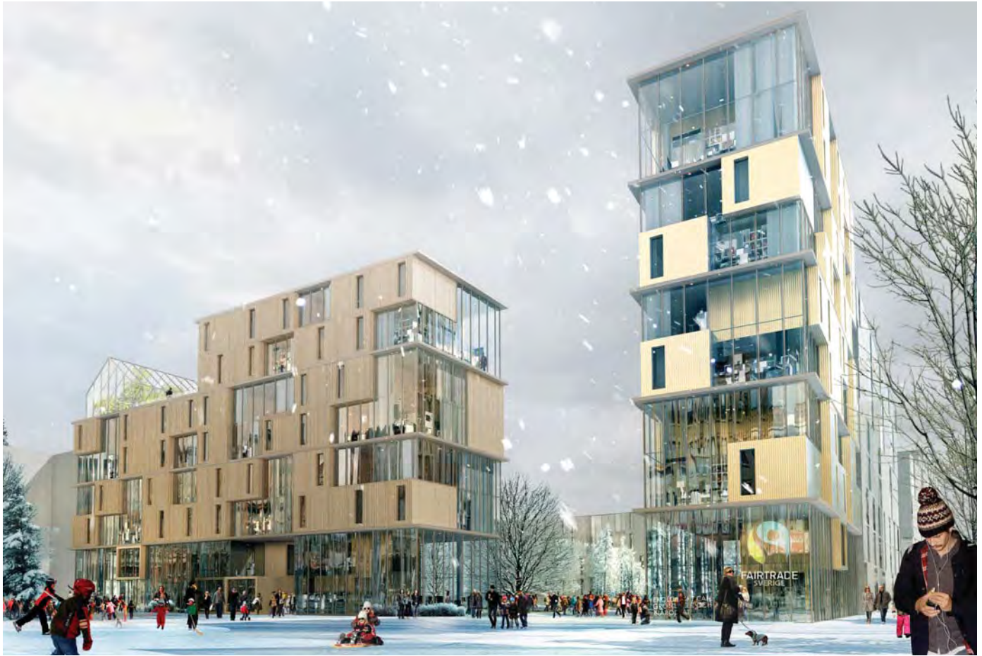
Delområden 6 och 7; byggherre - Midroc, arkitekt - Erik Guidice
