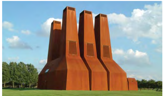
Värmekraftverk i Utrecht (Dok arkitekter)
