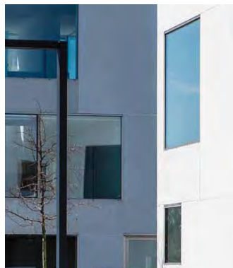
Prefabricerade betongelement med slipad och bemålad yta
