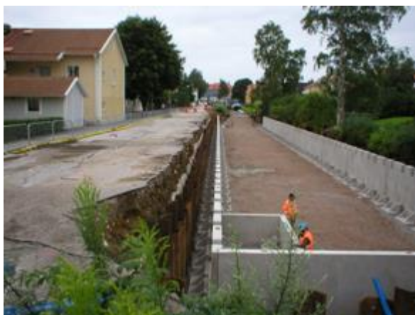
Bild 5.2 Byggande av betongmagasin 1000 m 3 under parkering, Växjö. Källa: Klimatanpassningsportalen
