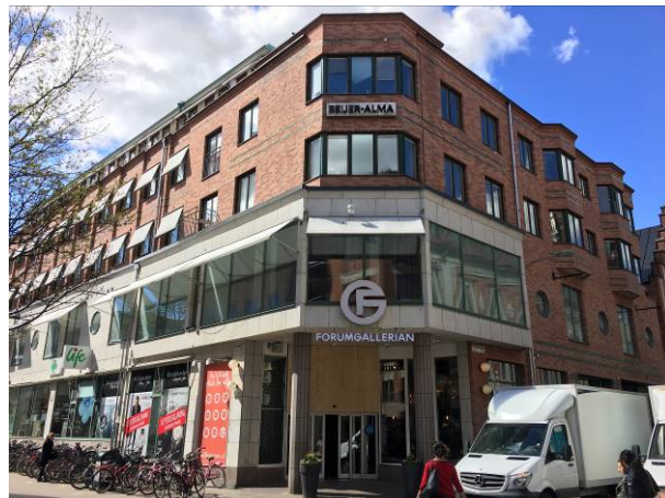
Forumgallerians 90-talsdel sedd från Dragarbrunnsgatan.
