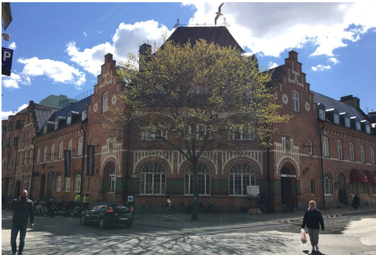
Spritpalatset sett från Dragarbrunnsgatan.
