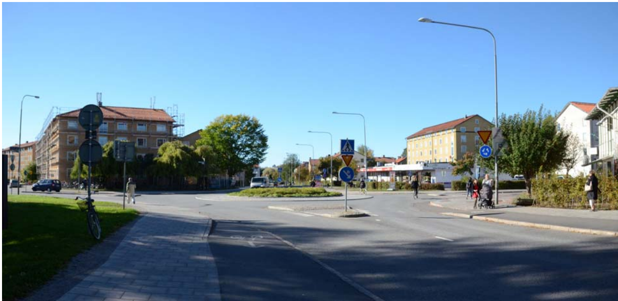
Foto. Korsningen S:t Johannesgatan-Rackarbergsgatan "Före".
