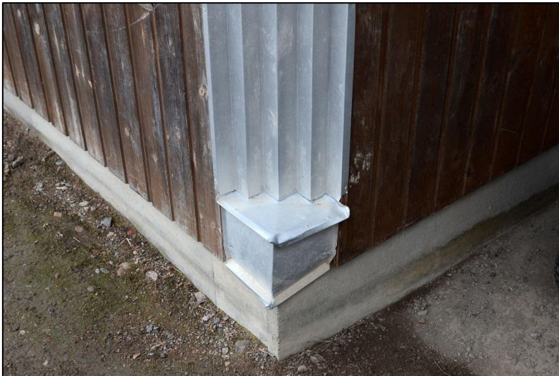
Hörnen på sina glashuskonstruktioner kläddes Bruno Mathsson med veckad plåt. Denna detalj kopierades vid tillbyggnaden av Rackarungen 1996-97. Foto: Martin Åhrén, a-sidan arkitektkontor.
