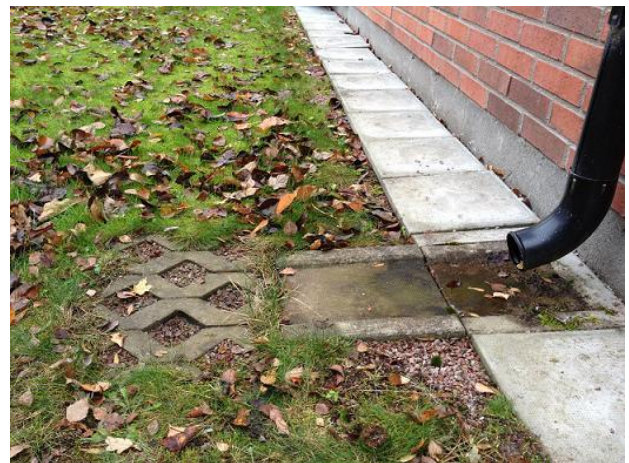
Figur 7. Utkastare till dagvattenbrunn respektive infiltration
