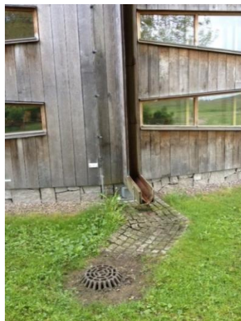
Figur 7. Utkastare till dagvattenbrunn respektive infiltration
