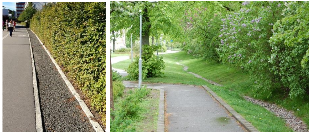
Figur 9. Avrinning i krossdike respektive svackdike med dränerande botten.
