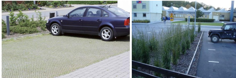
Figur 11. Parkering på gräsarmering till vänster. Parkering med LOD-plantering till höger.
