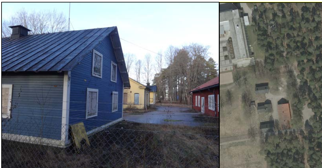
Figur 10; Byggnaderna i Fyrkanten.
