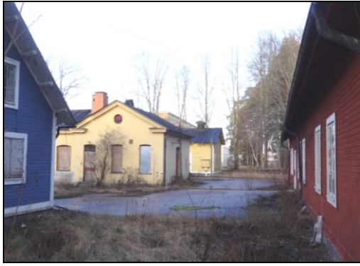
Figur 27; Byggnaderna i Fyrkanten.
