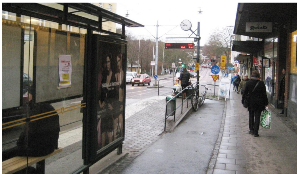
Bild 5 Kombinerad spårvagns- och busshållplats. Endast främre delen av plattformen är tillgänglighetsanpassad för spårvagnen.
