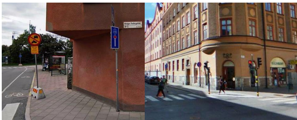
Bild 12 Skada på hushörn p g a påkörning.
