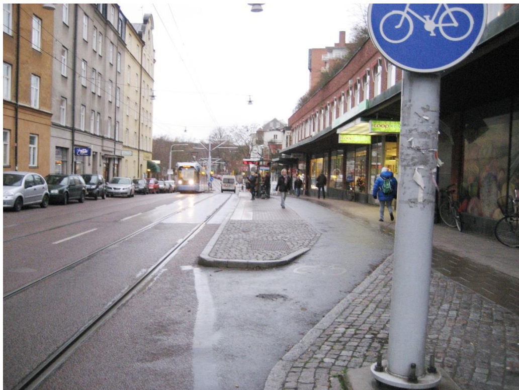
Bild 7 Cyklister leds in bakom hållplatsen (enkelriktad cykelbana)
