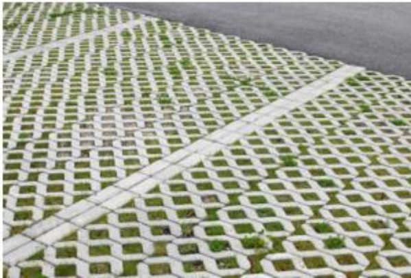
Figur 10: Genomsläppligt material som parkeringsyta.
