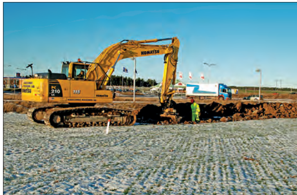
Fig. 12. Schaktning på norra änden av område 3. Torbjörn Jakobsson Holback står framför kameran och grävmaskinisten Victor Ekstrand sitter i maskinen. Foto från sydost: Thomas Eriksson.
