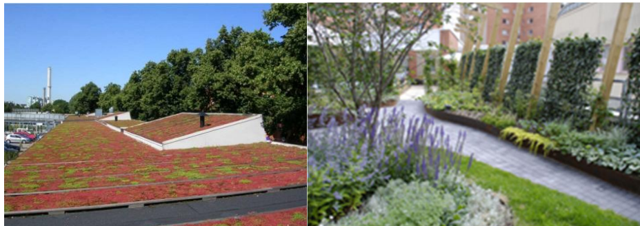
Figur 5. Gröna tak med olika karaktär och fördröjningsförmåga
