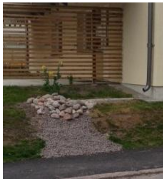
Figur 6. Utkastare med erosionsskydd
