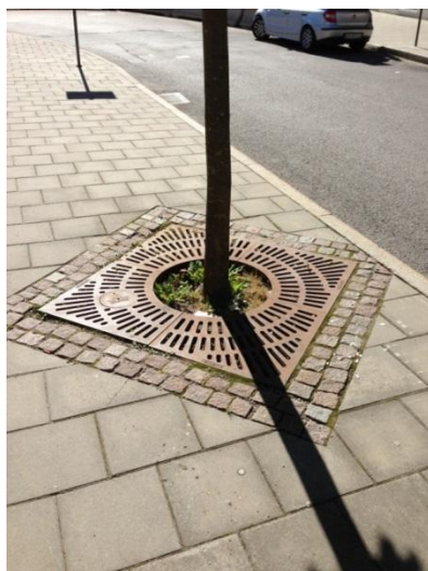
Figur 10. Träd som planterats i skelettjord dit dagvatten kan ledas och infiltrera.
