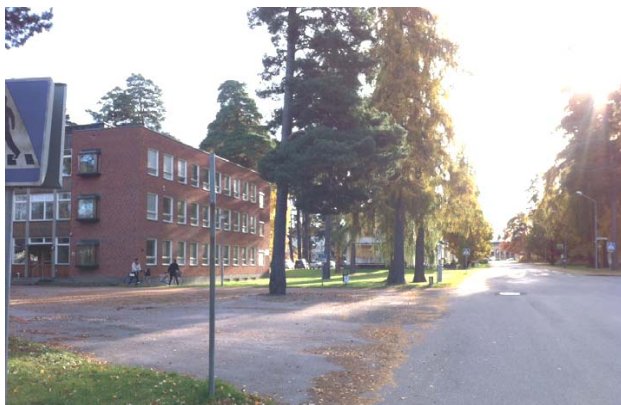
Foto som visar Ulleråkersvägen norrifrån, med administrationsbyggnaden till vänster (hus 87). Planområdet ligger till höger i bild.
