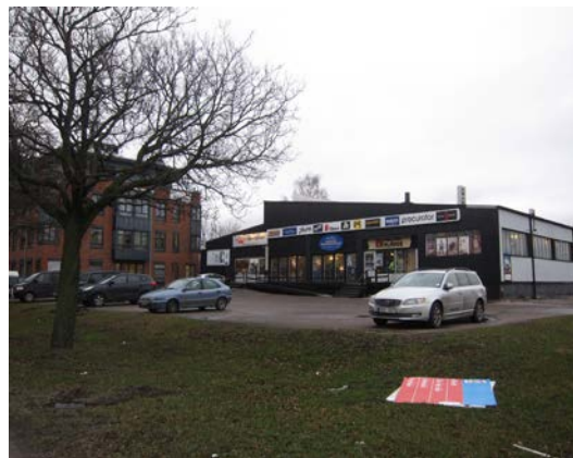
Befintlig byggnad sett från Kungsgatan
