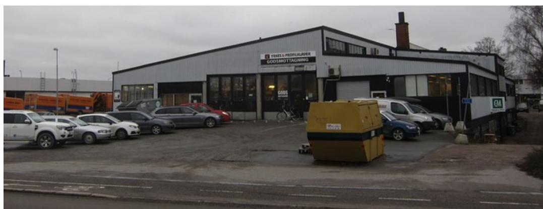
Befintlig byggnad sett från Vimpelgatan
