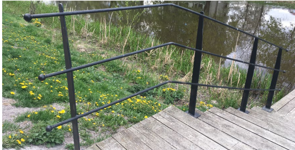
Smidesräcke på trappor, balkong och i anslutning mellan planteringar, och befintliga GC-vägen likt övriga sträckan uppströms längs med Fyrisån.
