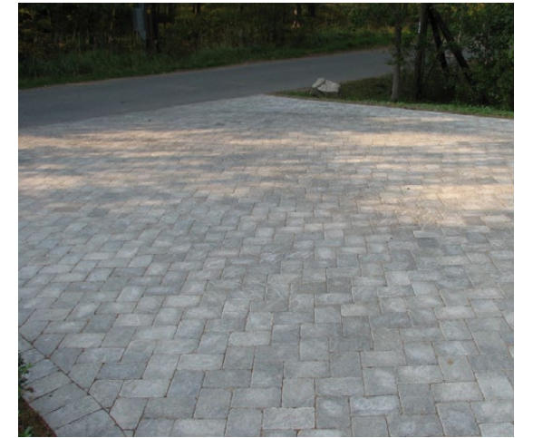
Markbeläggning i marksten lagt i mönset.
