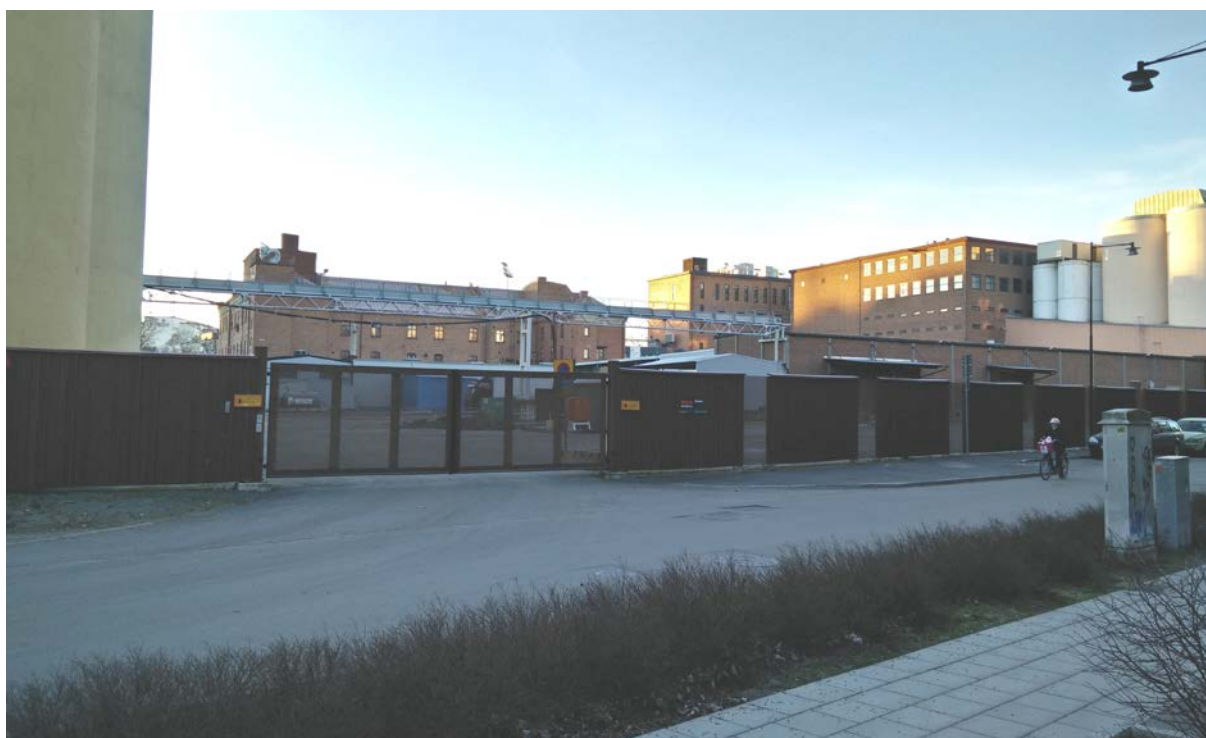
Foto som visar planområdet från Ångkvarnsgatan. Till höger syns makaronifabriken intill några av silotornen.
