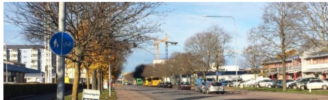
Kungsgatan från söder, Kungsängen 24:3 till vänster och 29:1 till höger. De nya bostadshusen norr om Kungsängen 24:3 skymtar till väster och De nya bostadshusen på Kungsgatans östra sida skymtar vid byggkranen.
